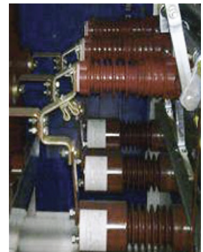
Sensor de tensión (VS-24-I [arriba]) y sensor de tensión de corriente (CVS-24-I [abajo]) instalados en una aplicación de conmutación
