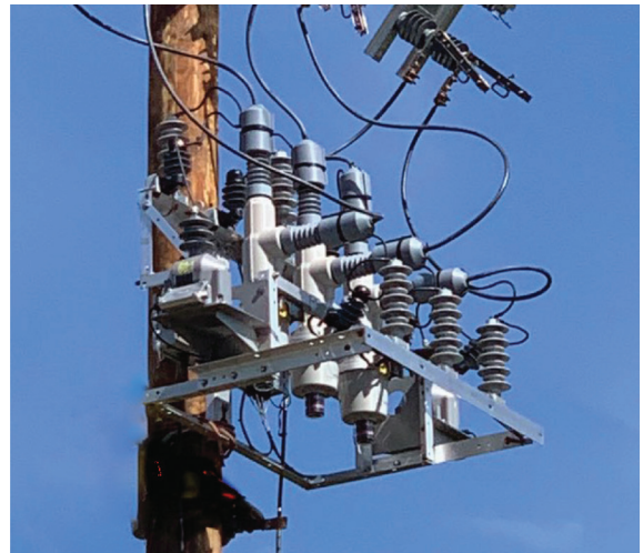
Protección y medición: Instalación de instalaciones aéreas en reconector Viper®-ST de G&W Electric (VS-27-0)
